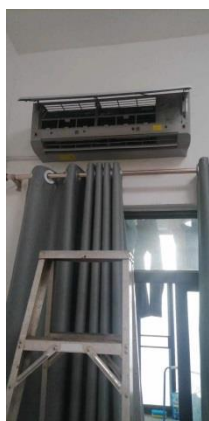
ภาพถ่ายที่ 2.2-17 การทำความสะอาดเครื่องปรับอากาศ
